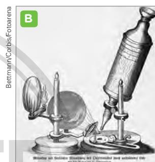
Microscópio de Hooke (cerca de 18 cm de altura), cujo poder de aumento era limitado: não ultrapassava 30 vezes.
