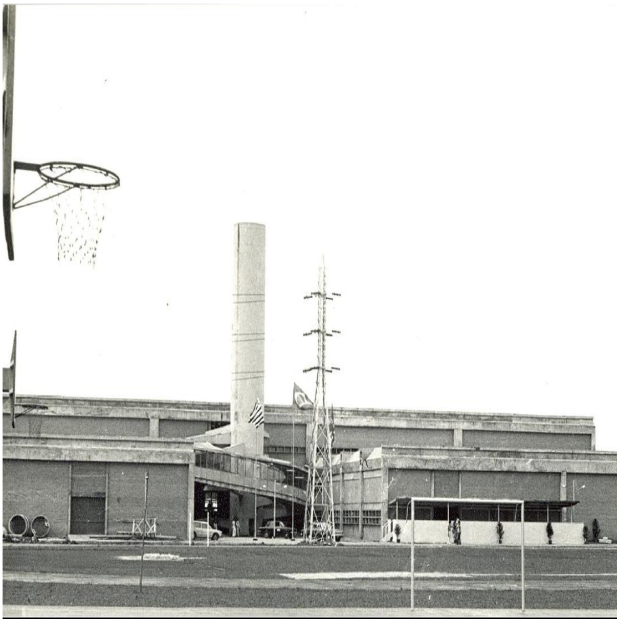
Fig. 1 Construção da sede própria do Câmpus São Paulo
