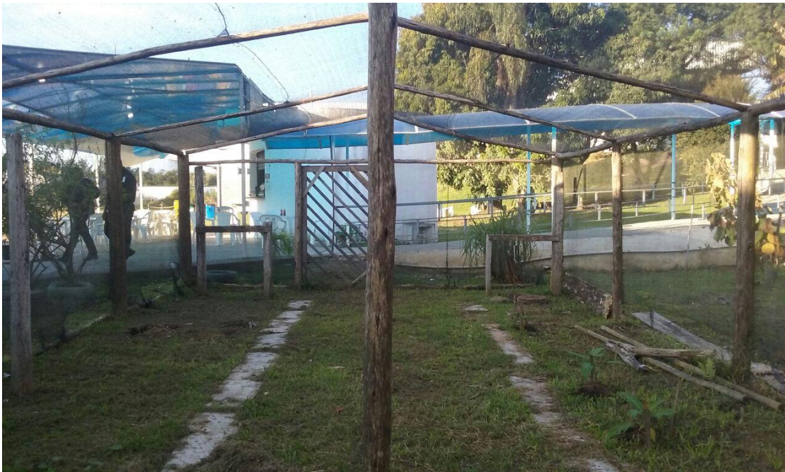
Figura 5. Estufa após a retirada de madeiras e limpeza.
